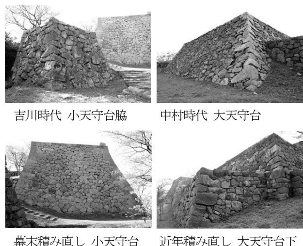
図6 米子城本丸部分の石垣の時代区分
