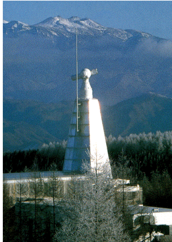
図 3 飛騨天文台ドームレス太陽望遠鏡の外観。高さ 20m の塔の上端に望遠鏡が固定されており、地上の大気のゆらぎの影響を受けないようになっている。
