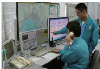
遠方監視制御機能を有したシステムを活用し、設備改修工事や自然災害等に伴う停電範囲の縮小、適正電圧の維持を行っています。
