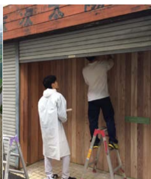
野波屋改修作業の学生
