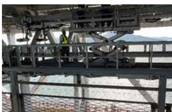
作業時の内面作業車の様子
