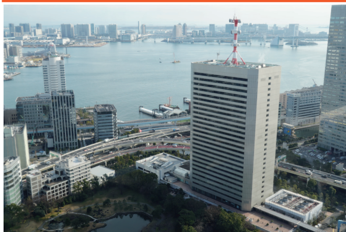
浜松町本社の外観
