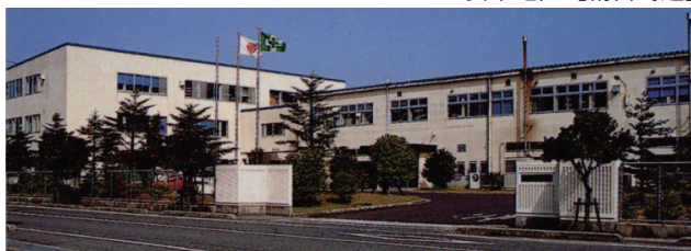
恵乃島地区【MIM、カッタ・パンチユニット製作】
