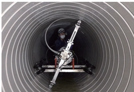
上下水道管のリニューアル工事
