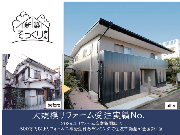
1棟丸ごとリフォーム「新築そっくりさん」施工例
