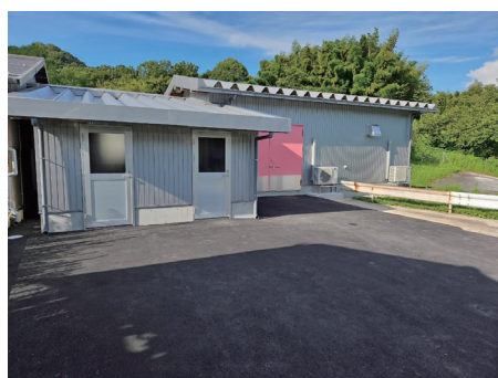
中小家畜試験場豚出荷施設新築ほか工事 完成写真
