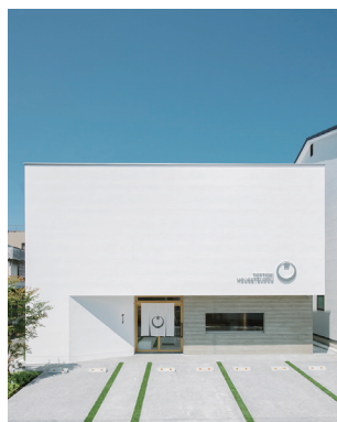
宝月堂様新築工事
