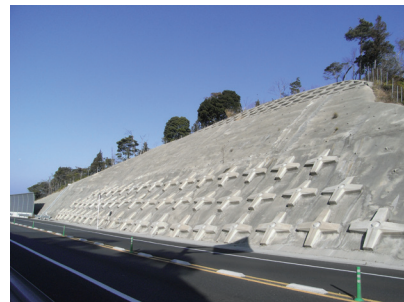
道路の法面保護
