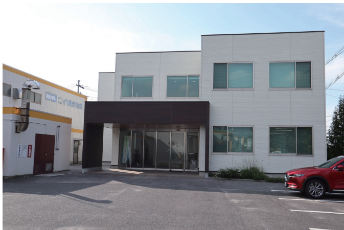
事務所棟 外観
