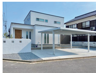
エクステリア施工事例
