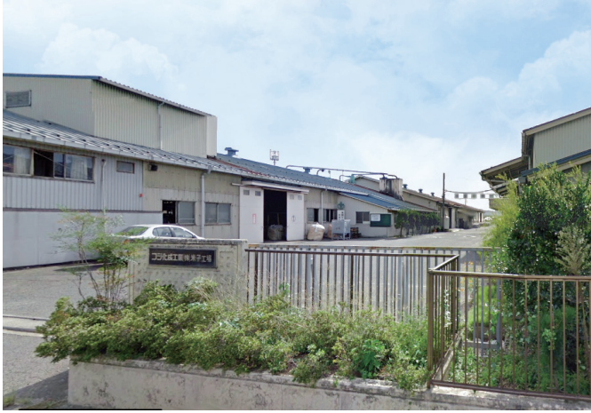
研究開発室 / 米子工場（リサイクル製品工場）
