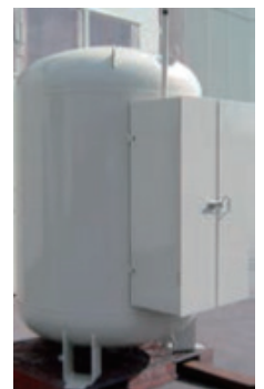
縦型バルク貯槽
