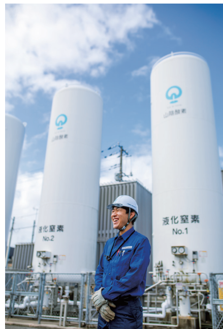
ガス供給設備の設計・施工管理・検査のほか、住宅の新築リフォームも自社の技術部門で行います。
