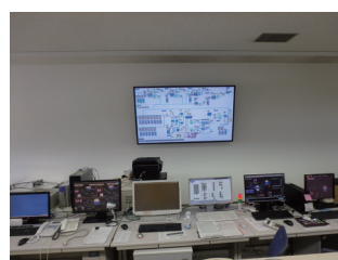
【米子市水道局】 中央送水ポンプ場監視装置改造工事
