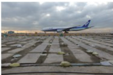
液状化対策工事
