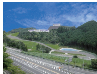
【米子市水道局】 新配水池電気工事
