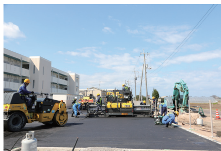
土木舗装工事
