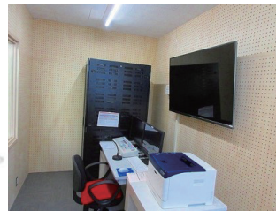
【三朝町】 防災行政無線デジタル化設備工事
