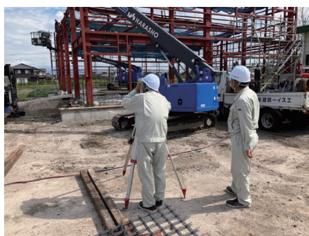
淀江防災備蓄倉庫新築建築主体工事 写真は鉄骨工事の管理状況
