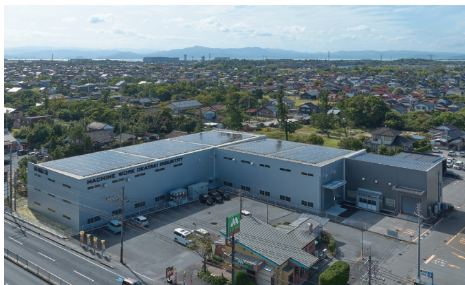
令和6年11月増設した新工場
