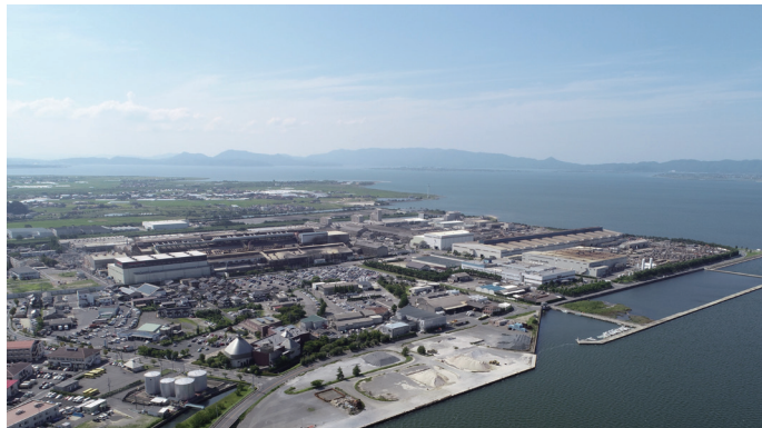
海岸工場（全景）
