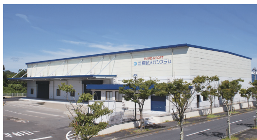
【第2組立工場棟外観】令和6年9月竣工の新工場
