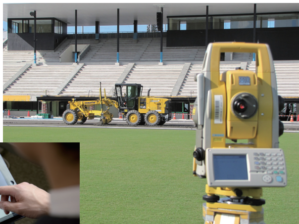
▲建設ICTの取り組み
