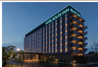
ホテルルートイン米子
