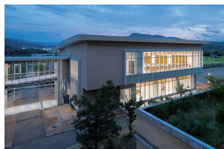
鳥取環境大学本部・講義棟増築工事
