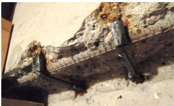
写真1 集合住宅梁の欠損改善計画・監理
