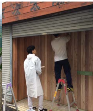
野波屋改修作業の学生
