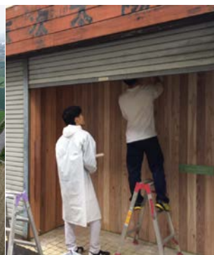
野波屋改修作業の学生
