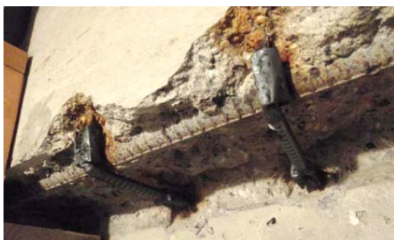
写真1 集合住宅梁の欠損改善計画・監理
