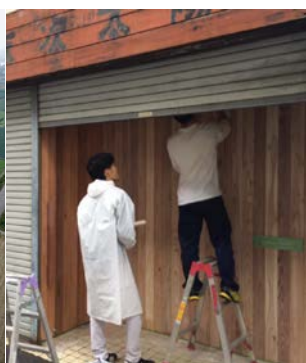
野波屋改修作業の学生
