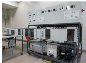
空調システム実験
