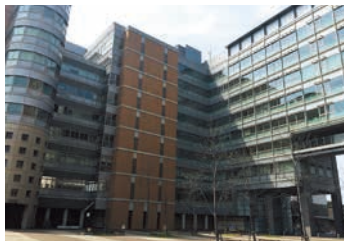
平成30年9月に移転が完了した 伊都新キャンパス
