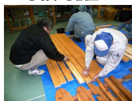
【写真8】塗装作業
