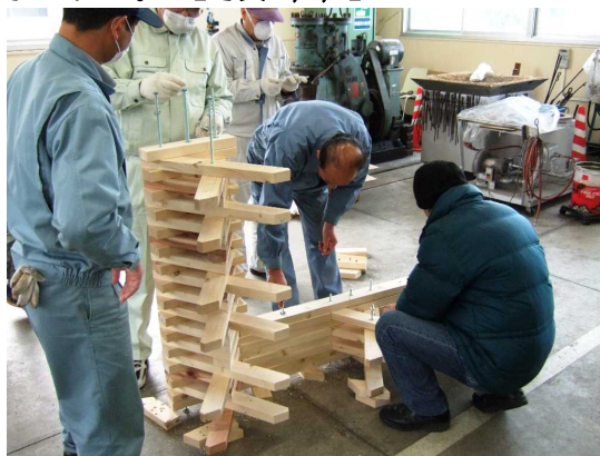
【写真1】製作状況1
