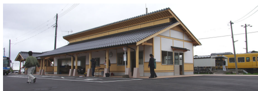
写真1 JR岸本駅前の竣工時の様子
